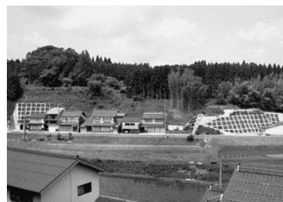
山地災害危険地区における治山工事
