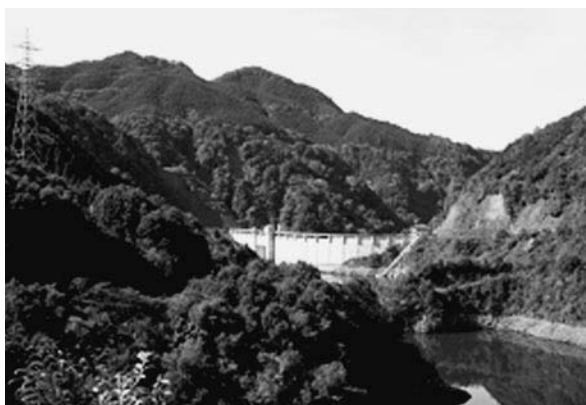
「大長見ダム」 浜田市 水源かん養保安林
