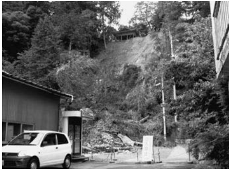
災害関連緊急治山事業（邑南町）
