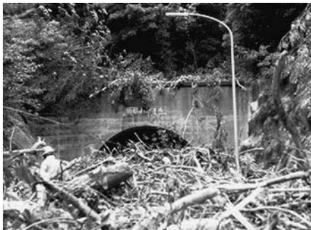
災害関連緊急治山事業（隠岐の島町）
