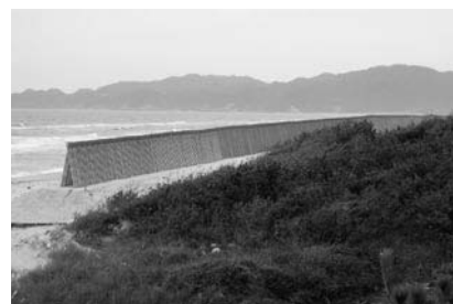
間伐材の防風柵により海からの季節風を防ぐ
