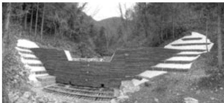
(間伐材型枠を残置した治山ダム)
