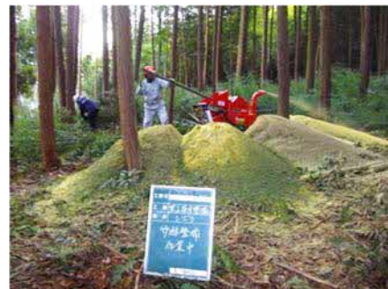
（使用する資機材の様子）
