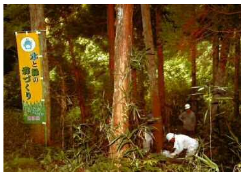
(防腐処理・基礎工事)
