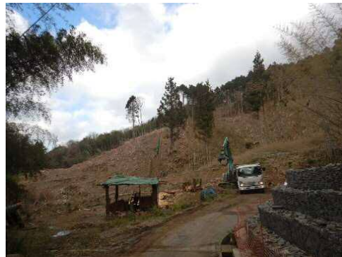
(経営管理実施権に基づく森林整備)
