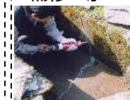
水路のひび割れ補修
