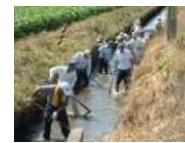
水路の泥上げ
