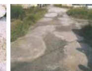
農道の窪みの補修
