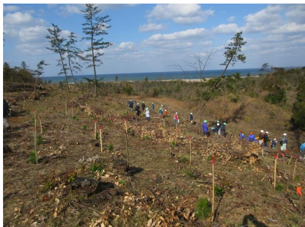
■1時間の作業で全ての植栽ができました。
