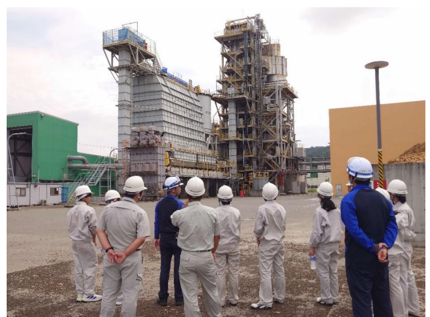
木質バイオマス発電所の見学
