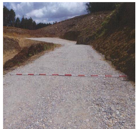
中規格作業道の完成横断
