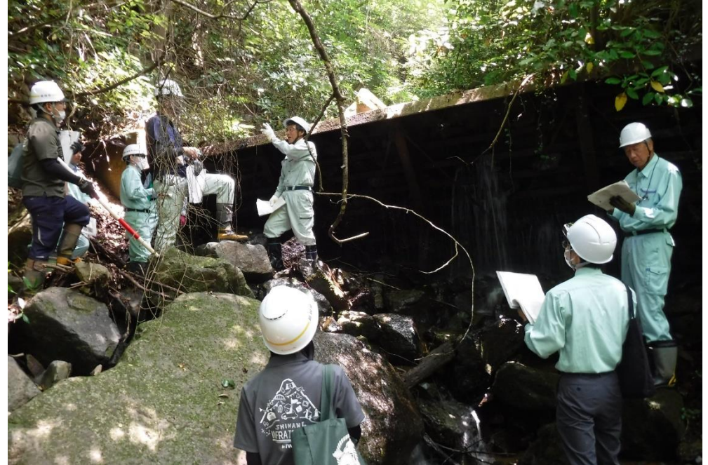
谷止工(鋼製)の点検中
