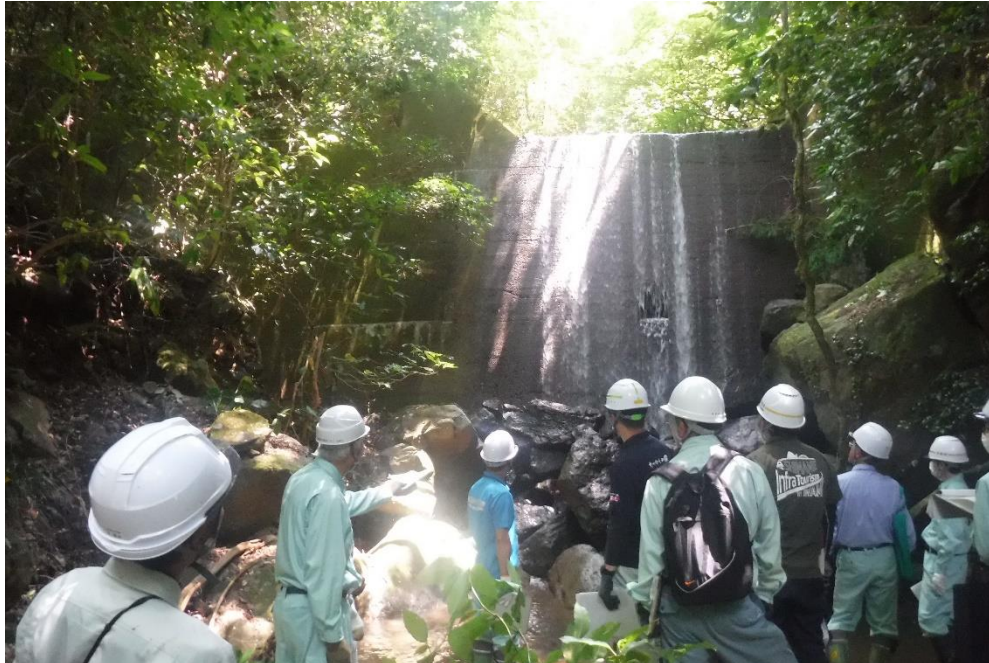
谷止工(コンクリート製)の点検中
