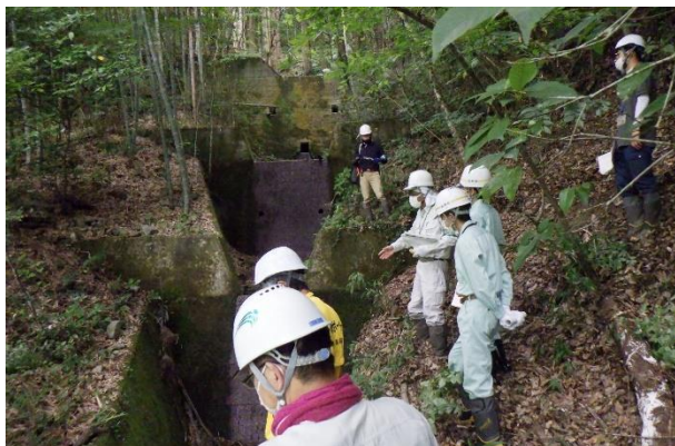
谷止工(治山堰堤)の点検
