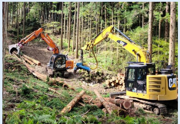
森林作業道上で伐倒・造材する林業機械
