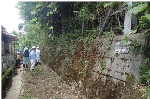
土留工の点検中
