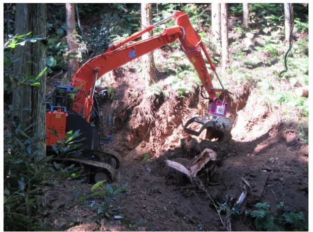
作業道作設の実演をする林業機械
