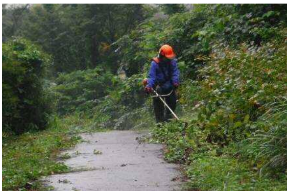
歩道（巡視路）の刈払い
