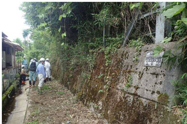
土留工の点検中
