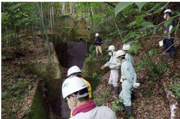
谷止工（治山堰堤）の点検
