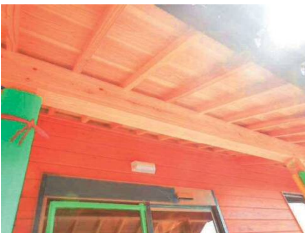
正面玄関梁（スギ）
