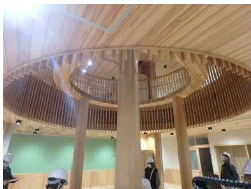
小学校校舎 玄関ホール
