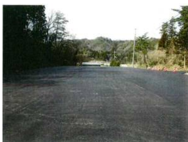
整備された中間土場
