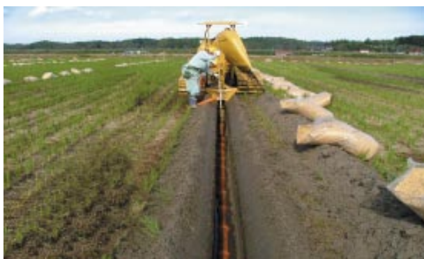
暗渠排水を施工して大規模な大豆栽培を展開 (安来市宇賀荘町)
