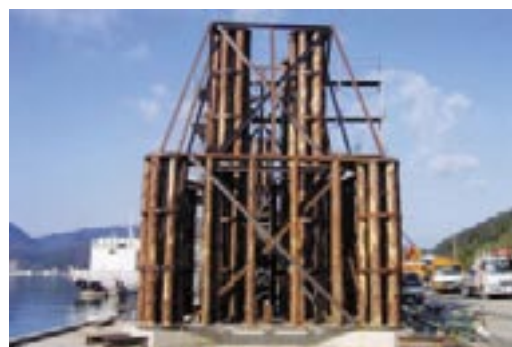
各地における市町村独自の漁場整備 (間伐材を利用した魚礁)
