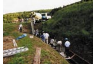
集落で行われる用水路の補修作業
