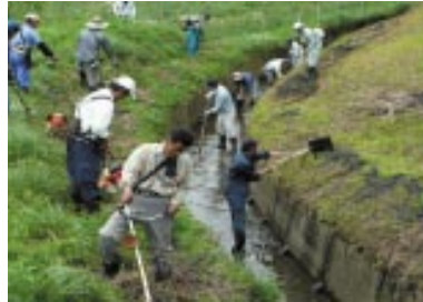
集落全員参加で行う水路の草刈りや泥上げ作業
