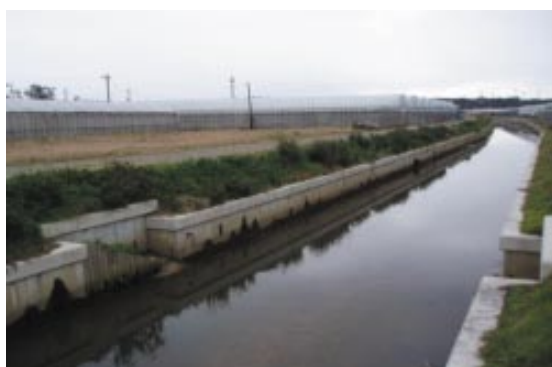
ブドウ団地内を走る排水路の改修 (出雲市浜町)
