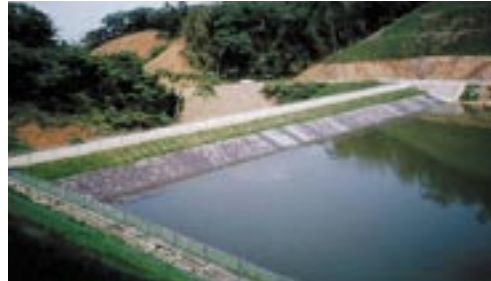
成丈ため池（松江市鹿島町）
