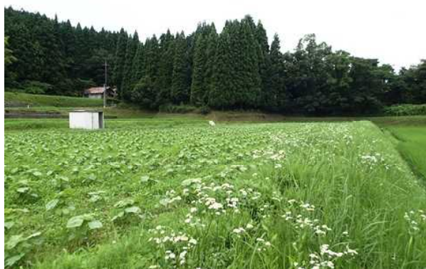
◆弾丸暗渠施工ほ場
