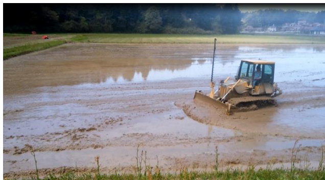
4/19 ほ場均平化（水整地）
