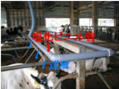
図1 配管した塩化ビニル管
