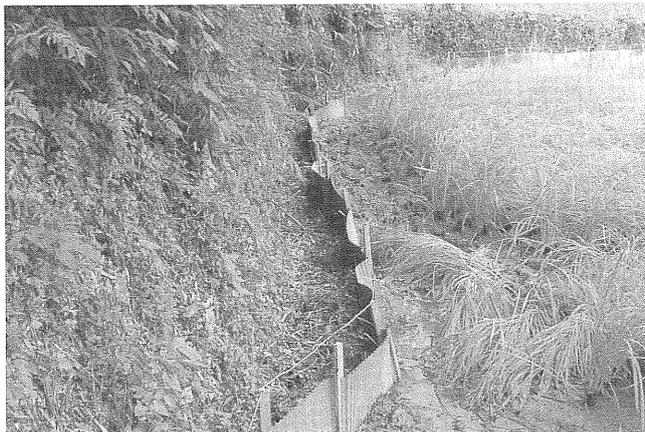
写真4 刈り払い終了後、防護柵を再び設置
