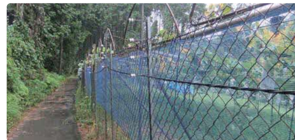
侵入防止柵の設置
