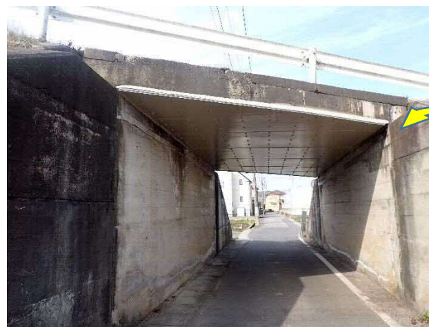
R4施工 割田橋
