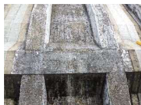
R4施工 縄久利雪覆坑
