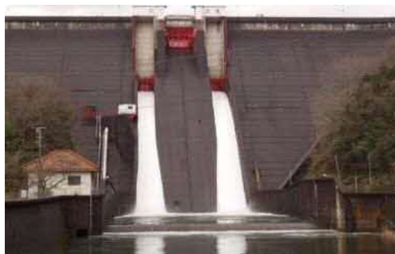
テレメータ放流警報設備
