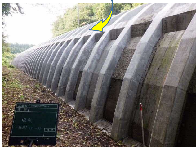
スノーシェルター 横梁修繕
