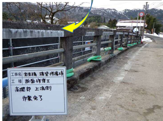
断面修復修繕
