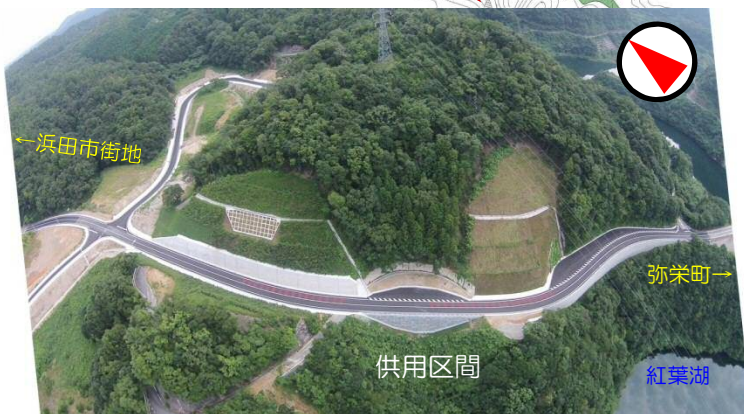
完成状況写真
