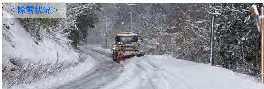
路面の凍結防止には塩化ナトリウム、路面凍結には塩化カルシウムを散布する
