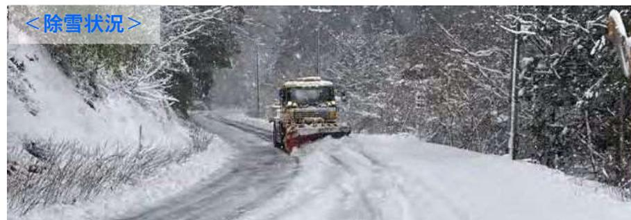
路面の凍結防止には塩化ナトリウム、路面凍結には塩化カルシウムを散布する
