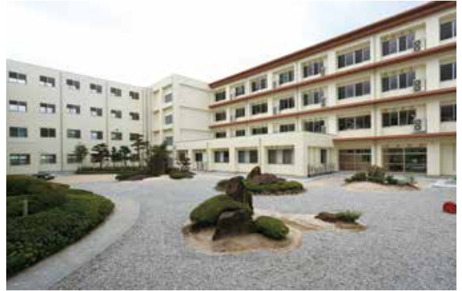
平成 27 年 7 月に完成した新校舎
