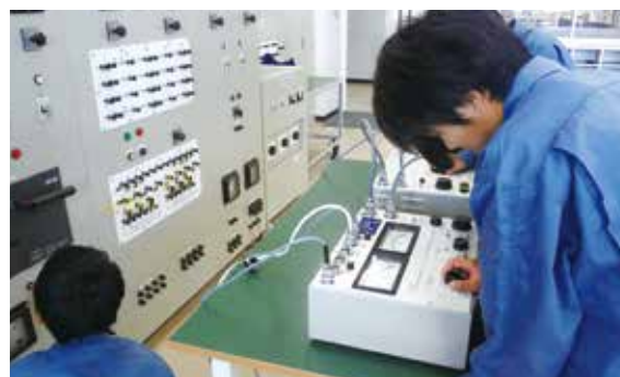
電力分野：模擬送電線実習
