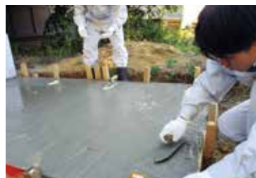
◆環境土木コース コンクリート実習
