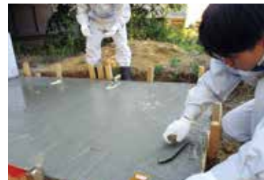
◆ 環境土木コース コンクリート実習
