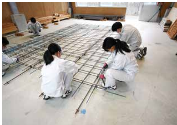
建築コース：スラブ配筋実習
