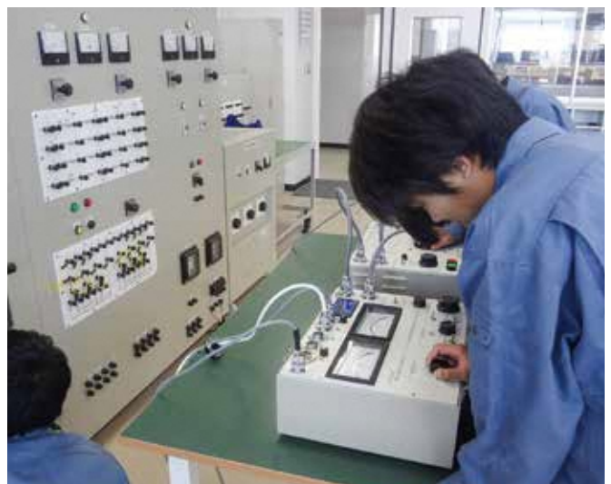
電力分野：模擬送電線実習
