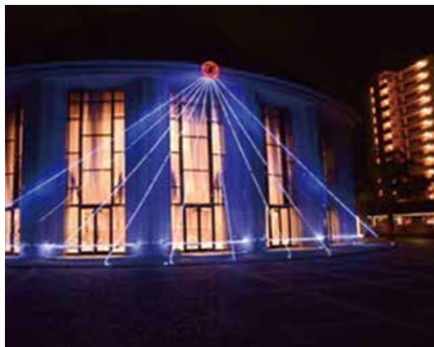
電子制御で美しく変化するイルミネーションの設置
