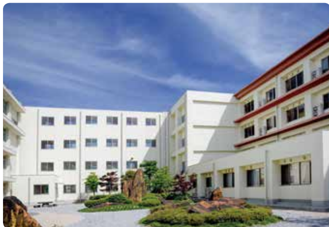
平成27年7月に完成した新校舎
