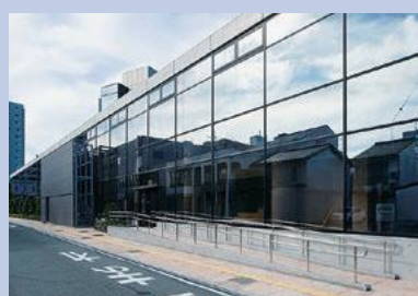
屋外スロープの設置事例
