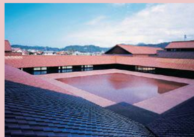
グラントワ（内藤 廣：益田市）
