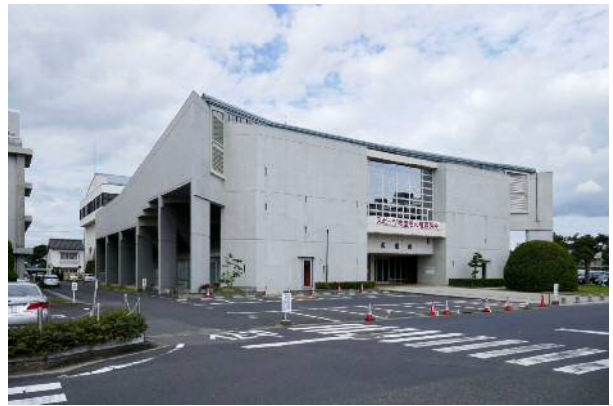
島根県立武道館
