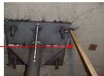
写真-解 6.2 打音検査作業状況
