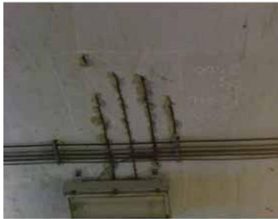
写真-2 鋼材腐食の例
