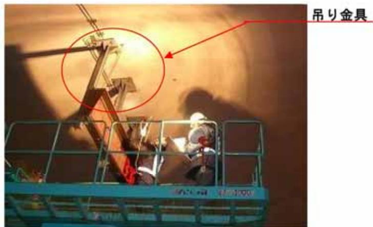
写真-解 6.3 触診作業状況
