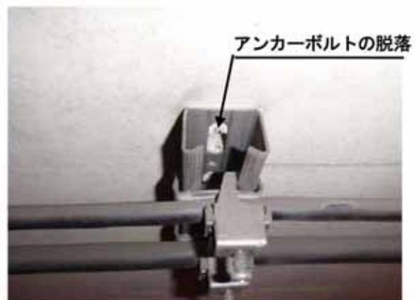
付写真-1.13 固定金具の腐食とアンカーボルトの脱落の例
