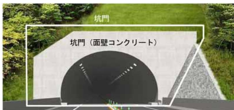
図-7.2 点検対象箇所(トンネル坑口部)
