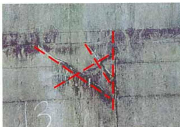
写真-1 ブロック化したひび割れの例
