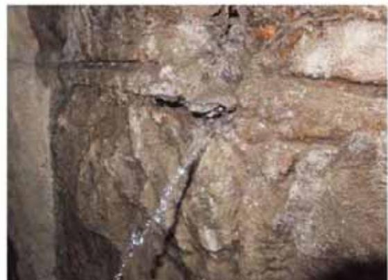
付写真-1.7 漏水(噴出)している例
