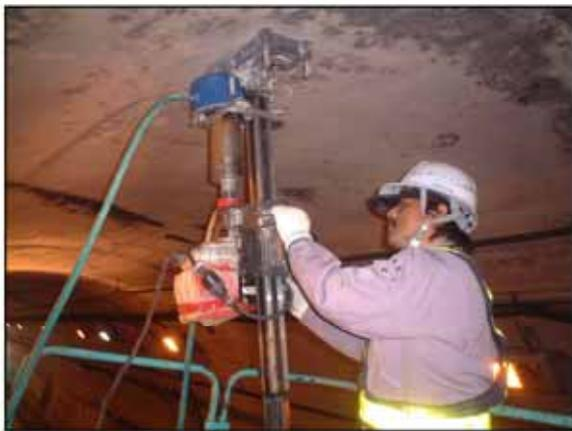
写真-2.1 コア削孔状況
