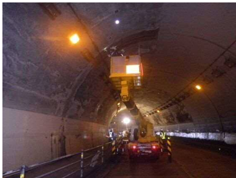
写真 3-1 FRP ネット設置状況
