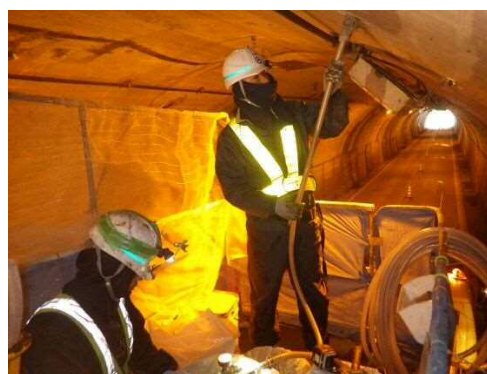
裏込注入状況
