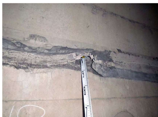
壁面打継部の剥離
