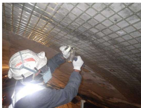
写真 3-1 FRP ネット設置状況
