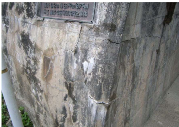
抗門面壁のひび割れ
