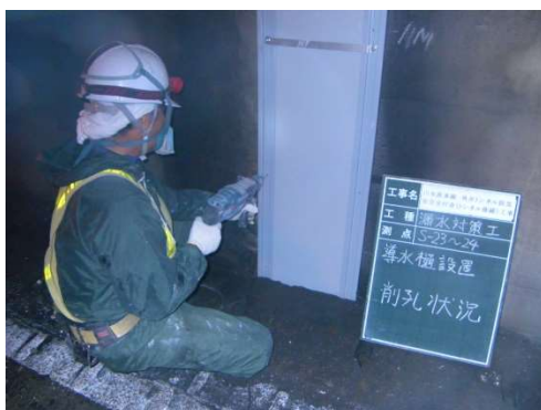
写真 3-2 線導水工
