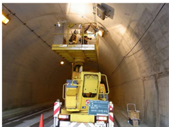
写真 2-1 トンネル点検状況
