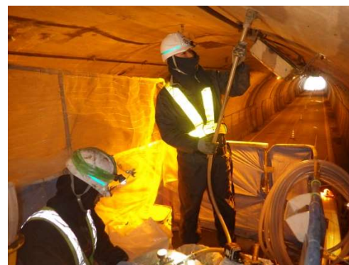
裏込注入状況
