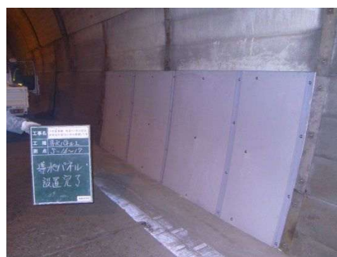
写真 3-3 面導水工
