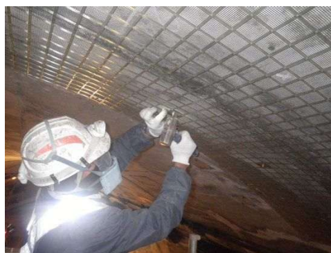
写真 3-1 FRP ネット設置状況
