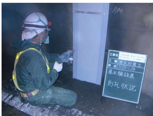
写真 3-2 線導水工
