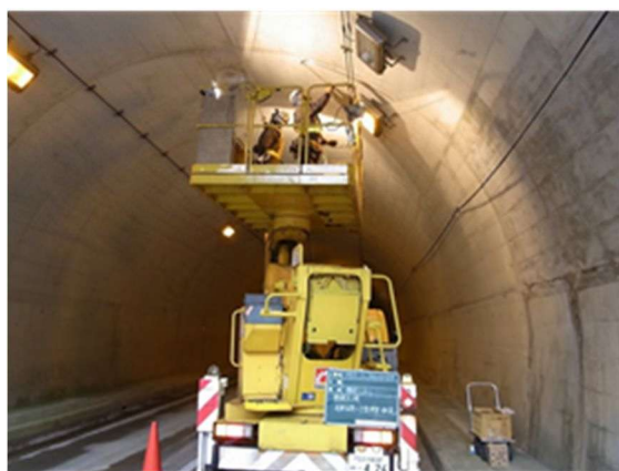
写真 2-1 トンネル点検状況
