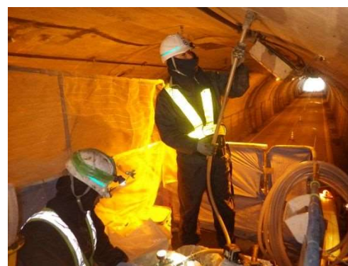
裏込注入状況
