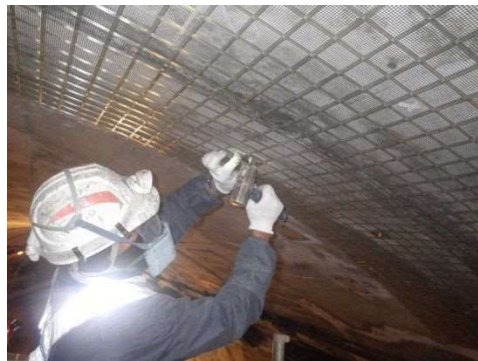
写真 3-1 FRP ネット設置状況
