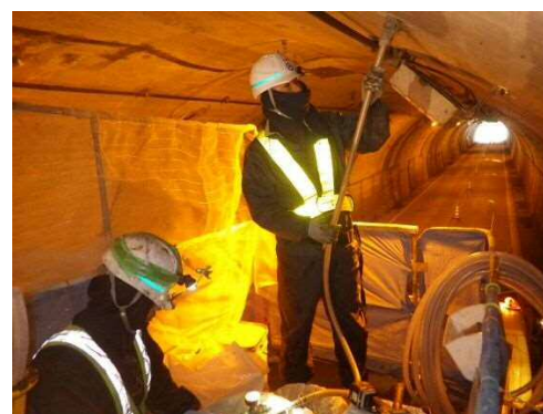
裏込注入状況
