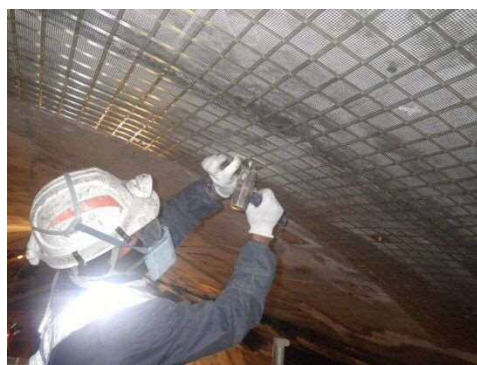
写真 3-1 FRP ネット設置状況
