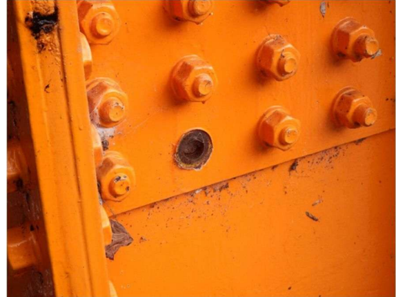
取付ボルト (F11T) の破断
