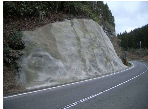
写真 3-1 既設モルタルの撤去+再吹付
