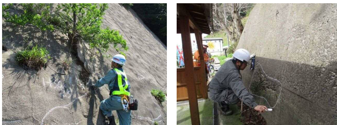
写真 2-1 法面構造物点検状況
