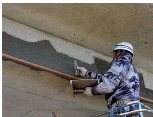
写真4-3 断面修復状況
