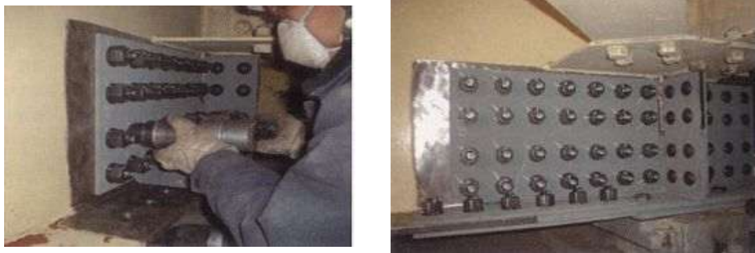
写真4-1 当て板工実施状況
