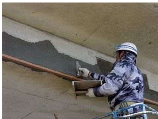
写真 4-3 断面修復状況
