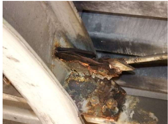
ガセットプレート部分の腐食
