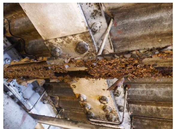
照明取付レールの断面欠損、破断
