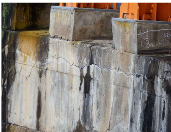
受台のひび割れ
