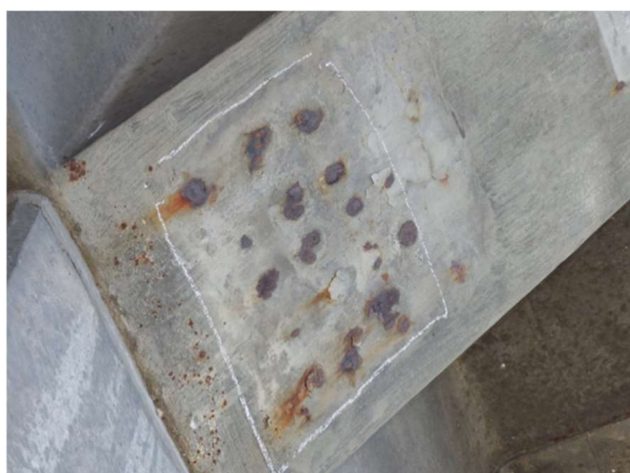
PC 鋼材からの錆汁（主梁）
