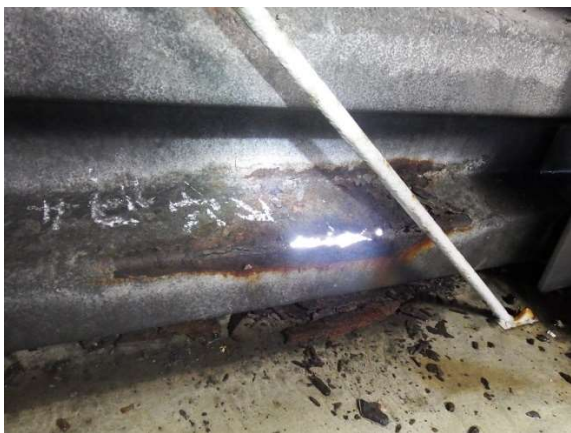
頂版の断面欠損
