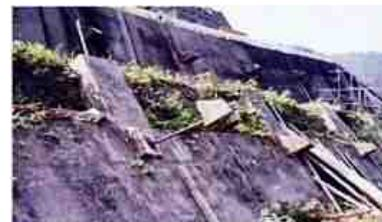
写真 2.32 頭部コンクリートの突出
