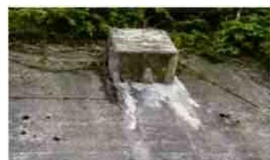
写真 2.33 遊離石灰の流出痕跡
