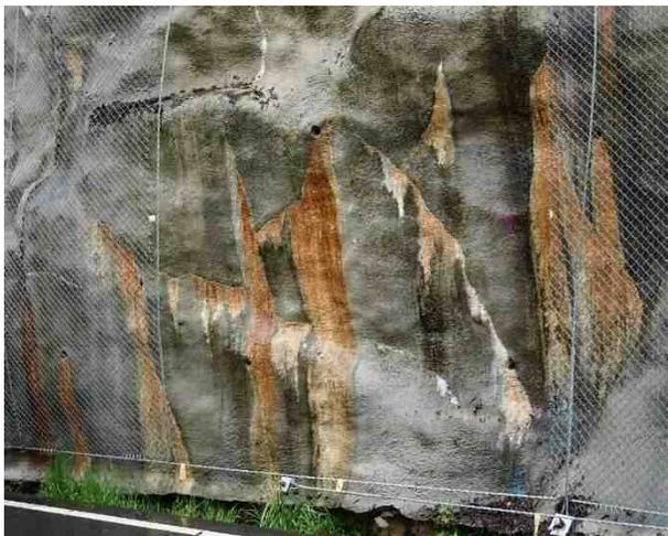
写真 2.7 モルタル表面の変色の例
