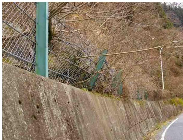
写真 2.28 支柱の倒れ
