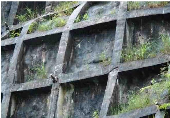
写真 2.14 法枠の割れ
