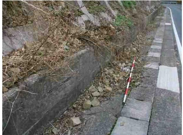
写真 2.16 法枠内にある浮石からの落石
