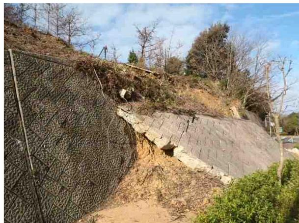
写真 2.25 ブロック積み擁壁の崩壊例
