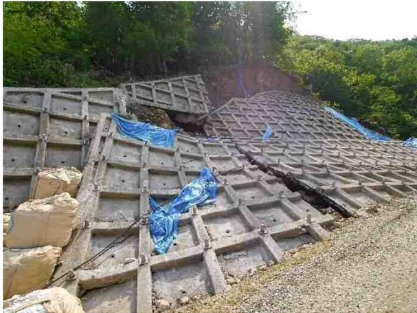
写真 2.12 法枠の崩壊の例
