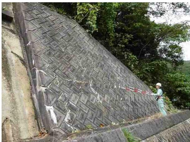
写真 2.26 水平方向に連続するひび割れ
