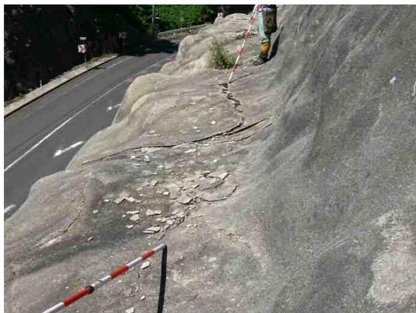
写真 2.6 小段における打音異常箇所の例
