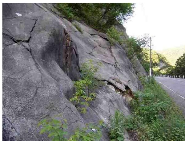
写真 2.5 浮き(全体的・寸法大の例)
