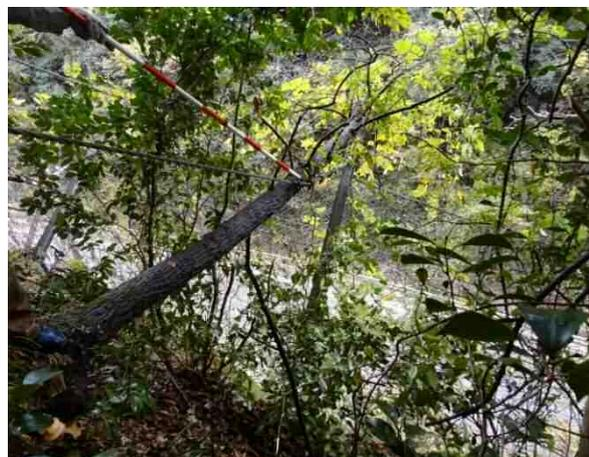
写真 2.18 倒木による支柱の傾倒
