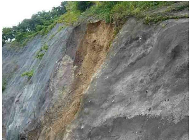
写真 2.1 モルタル吹付の崩壊例
