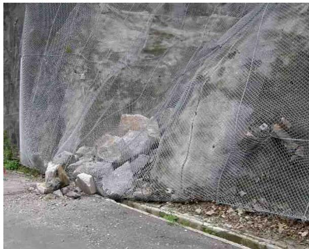
写真 2.21 ネット外への飛散
