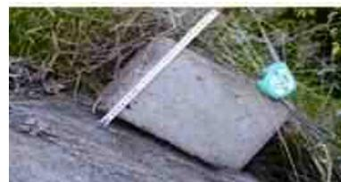
写真 2.31 頭部コンクリートの浮き上がり
