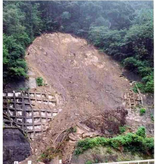
写真 2.13 法枠を巻き込んだ斜面崩壊
