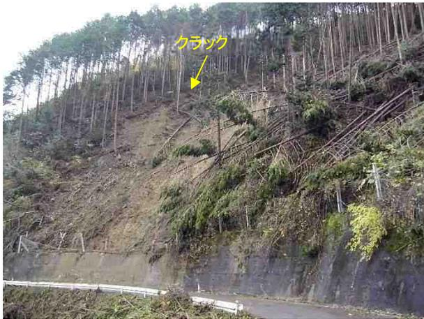
写真 2.9 崩壊斜面のクラック
