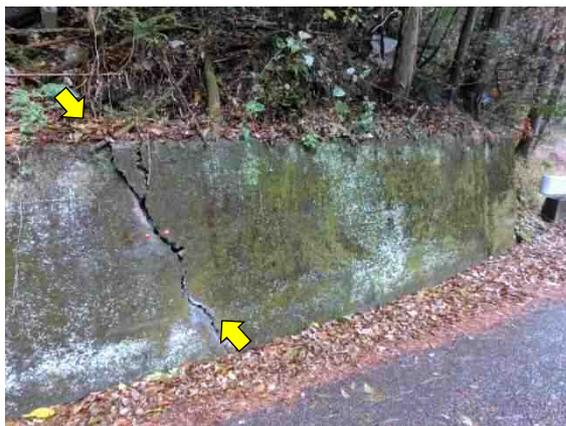
写真 2.22 段差のある開口ひび割れ
