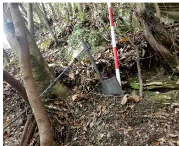
写真 2.19 アンカーの抜け出し
