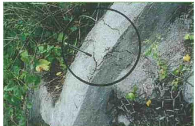
写真 2.15 法枠の割れ
