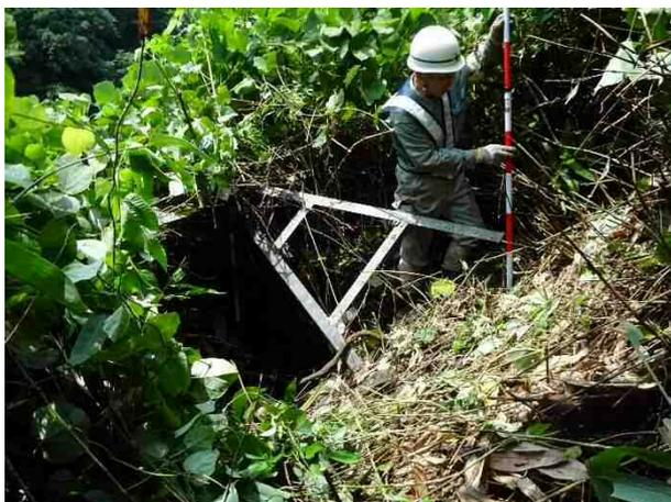
写真 2.17 植生に押し倒された支柱
