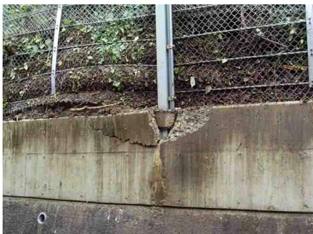
写真 2.29 支柱周りの擁壁割れ
