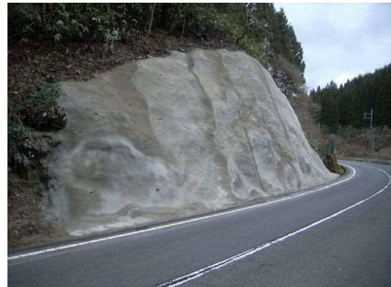
写真 3-1 既設モルタルの撤去+再吹付
