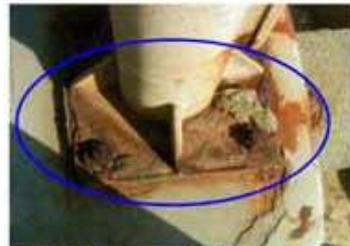
照明柱の取付部の腐食
