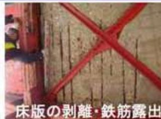
床版の剥離・鉄筋露出
