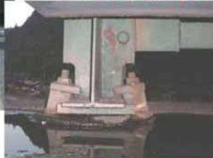
支承が破損し桁が下がっている
